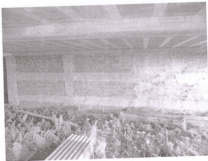
Foto 05: Parede/ contenção do subsolo.
