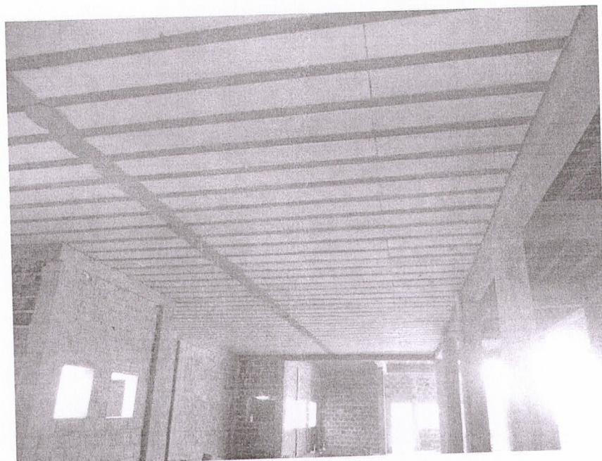
Foto 09: Lajes do térreo (futuro entrepiso).
