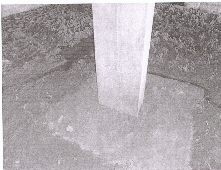
Foto 01: Sapatas/ pilares do subsolo.
