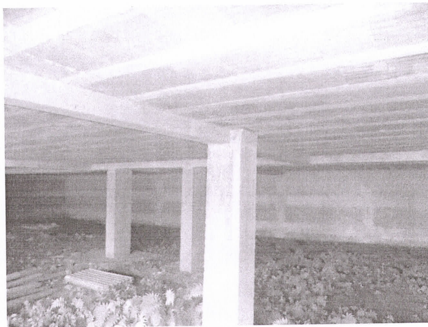
Foto 03: Pilares/ vigas/ lajes do subsolo.
