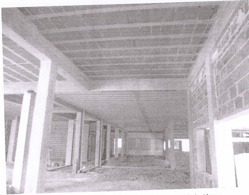
Foto 12: Pilares/ vigas/ lajes (futuro entrepiso) do térreo.
