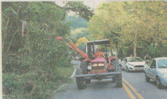
Manutenção será realizada em duas etapas
