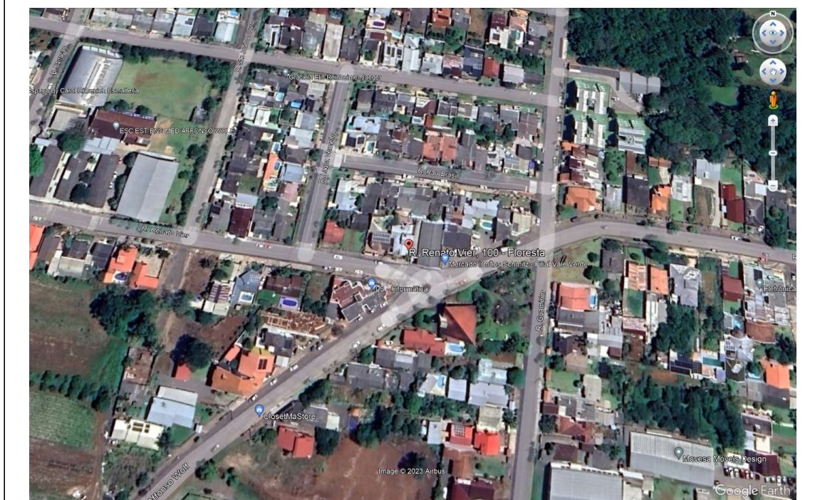
Imagem: Pontos de alagamento na Rua Renato Vier esquina com a Rua Afonso Wolf.
