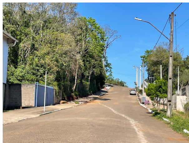
Imagem: Pavimentação por bloquetes.
