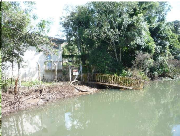
Imagem: Arroio Feitoria – Ponto de captação.
