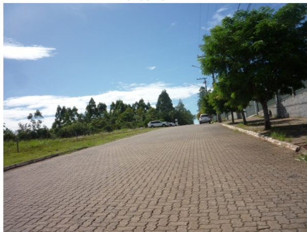
Imagem: Pavimentação por bloquetes na zona urbana.
