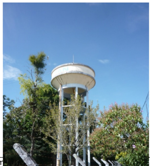
Imagem: Reservatório CORSAN Dois Irmão/RS.
