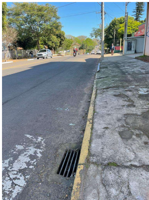
Imagem: Detalhe da sarjeta e grelha.
