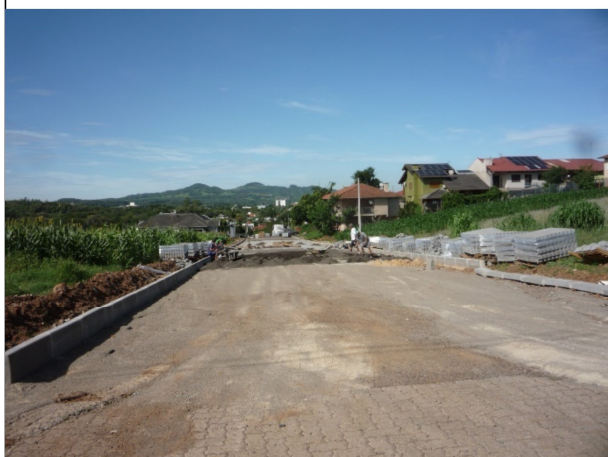
Imagem: Pavimentação sendo executada.
