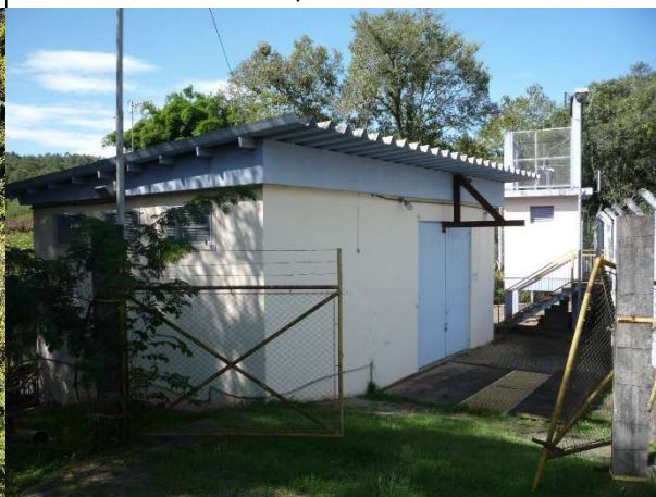
Imagem: Estação de bombeamento de água bruta para a ETA.
